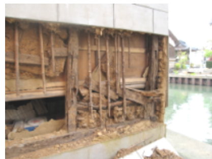
過去の水害時の浸水による土壁の劣化、下地の腐朽の放置が被害を拡大した例 *
