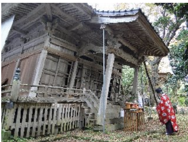
被災神社建物修復に向けての安全祈願祭(2009.11.3)
